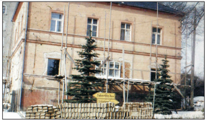
1975: Das Schulgebäude im Umbau
