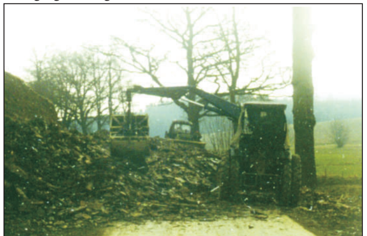
Anfang April 1980: Sprengung an der Straße nach Leubnitz zur Abtragung des Hanges. B.M./Fotos: U.S.
