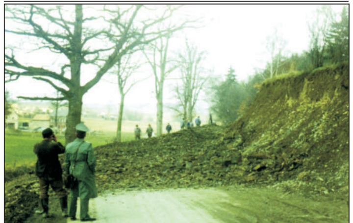
Anfang April 1980: Sprengung an der Straße nach Leubnitz zur Abtragung des Hanges. B.M./Fotos: U.S.
