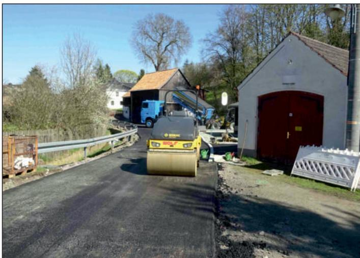
Foto rechts: Die Straße Am Teich erhielt nach der Verlegung der Abwasserleitungen nun eine neue Teerdecke.
