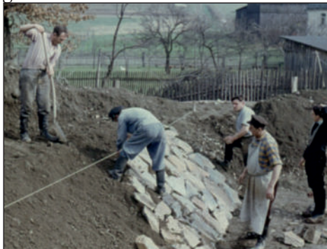
Befestigung des Teichdammes mit Bruchsteinen.
