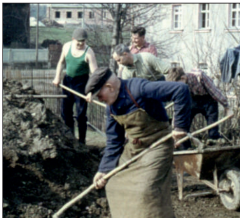
Erdarbeiten am Teichdamm. Im Vordergrund Reinhard Kanz.
